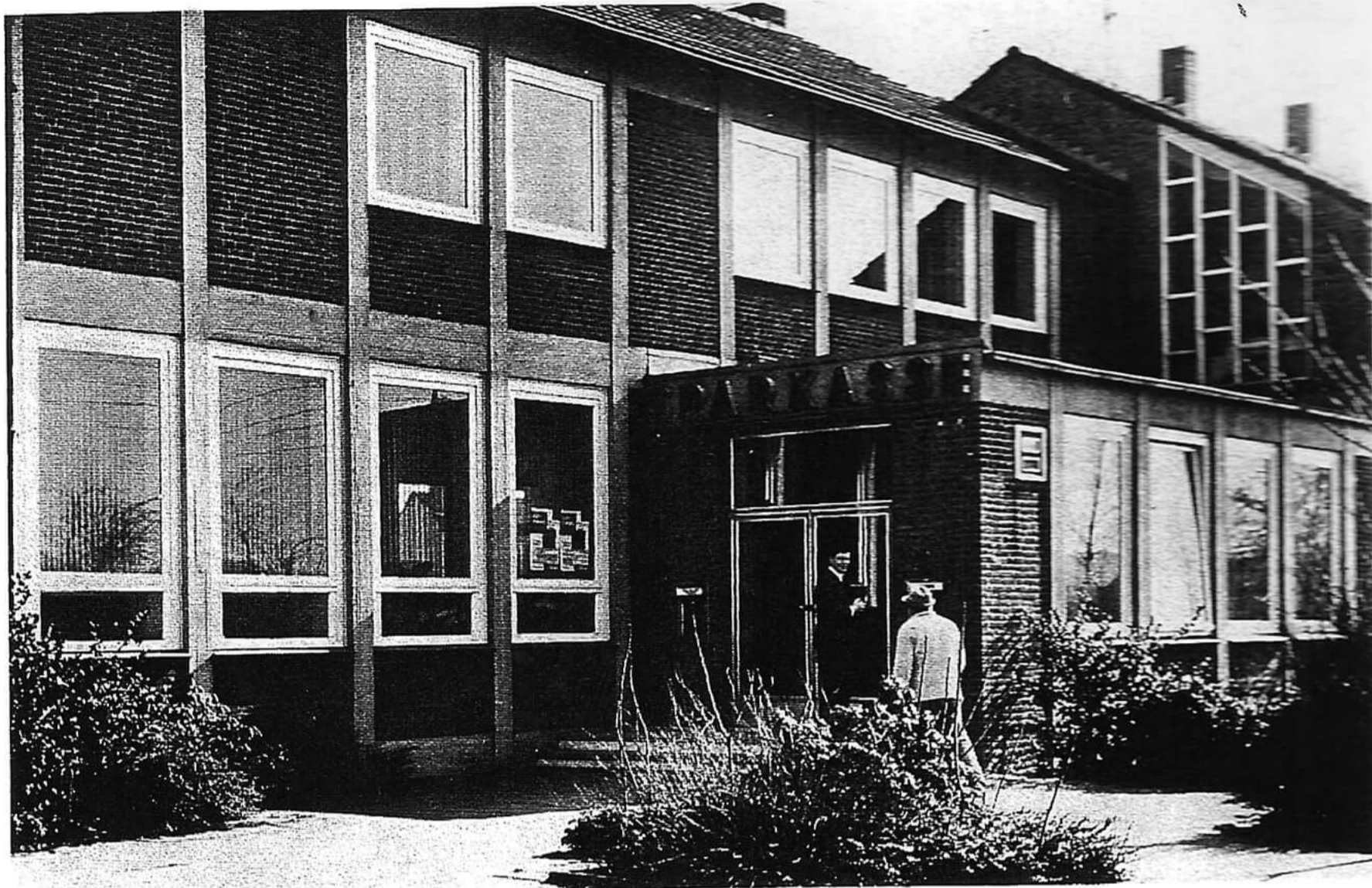
Hauptstelle Hünxe, Minnekenstege 1 (Neubau, bezogen am 15. März 1964)
